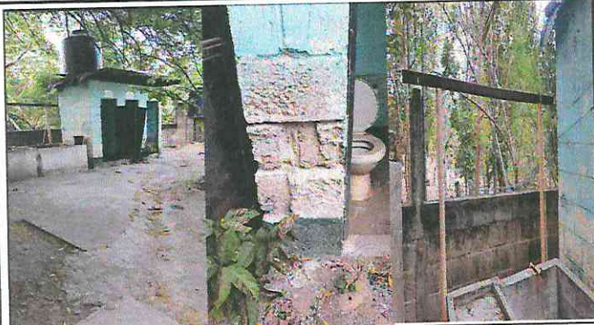
Foto 1: Mantenimiento y reparación de Puertas, repello y cernido a baños, galera en la pila.
